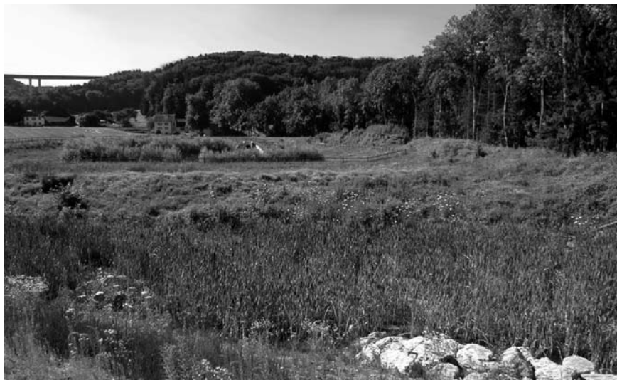
Imatge 5. Embassament de retenció d'aigües d'escolament de l'autopista A-1 en un biòtop humit.
